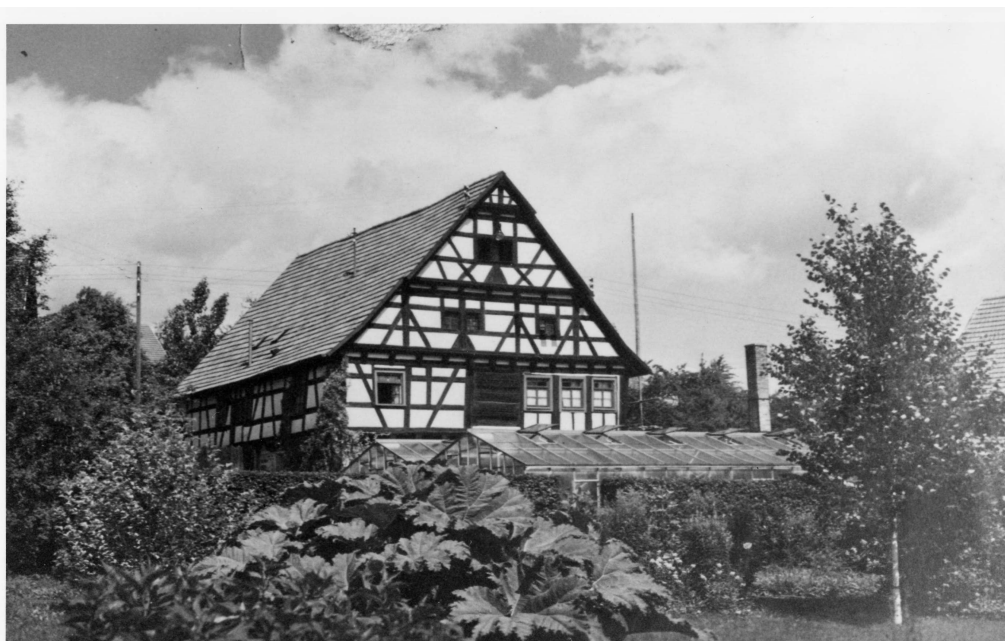
Haus des früheren Schultheißen Matthäus Rentschler – saniert - Mitte der 60er Jahre abgerissen
